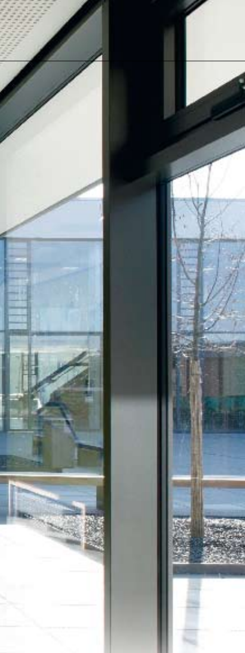
Die weitläufige und transparente Architektur der neuen Grund- und Hauptschule stellt hohe Ansprüche an die Gebäudetechnik, die hier gewerkübergreifend mit KNX gesteuert wird.
